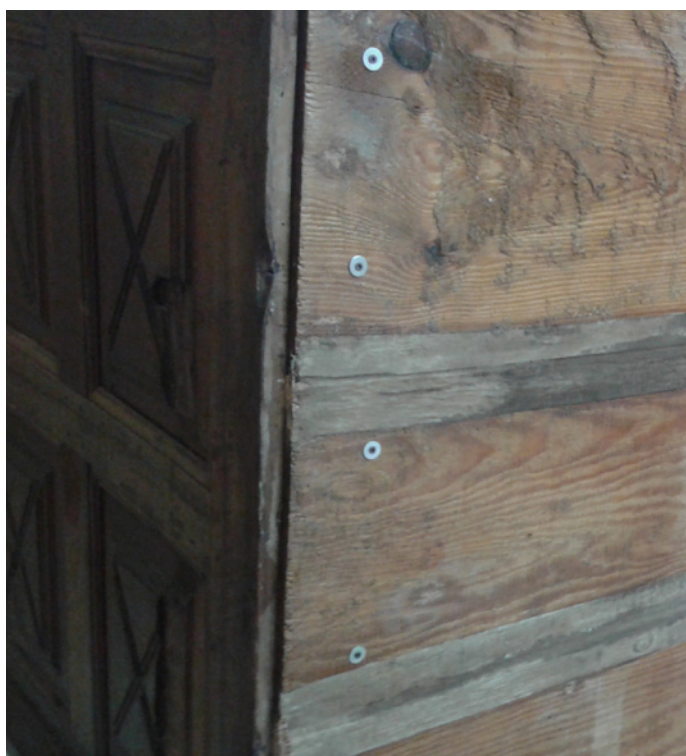
Tavole posteriori della cassetta fissate tramite viti a rivestimento elettrolitico per facilitare futuri smontaggi ed ispezioni.
