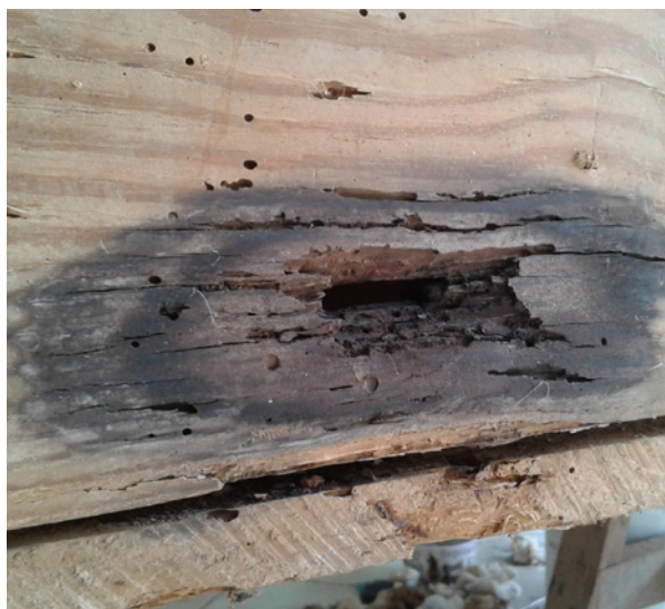
Necrosi da attacchi batterici prodotti da ossidazione da chiodo.
